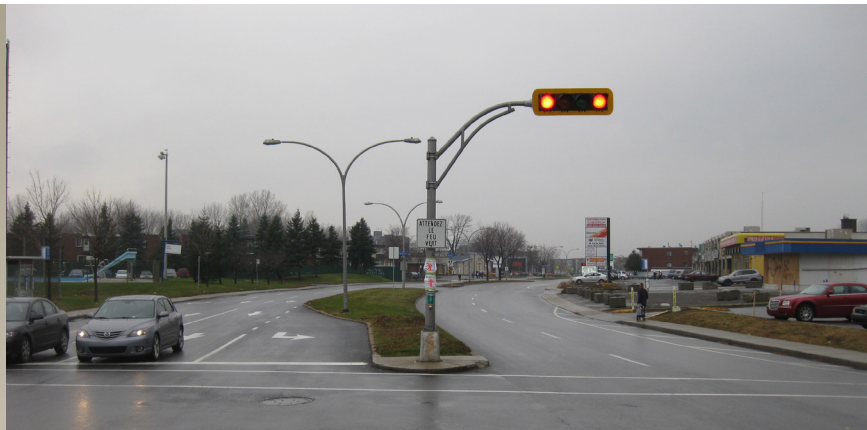
Photo 2: Nombreuses voies du boulevard Cartier
