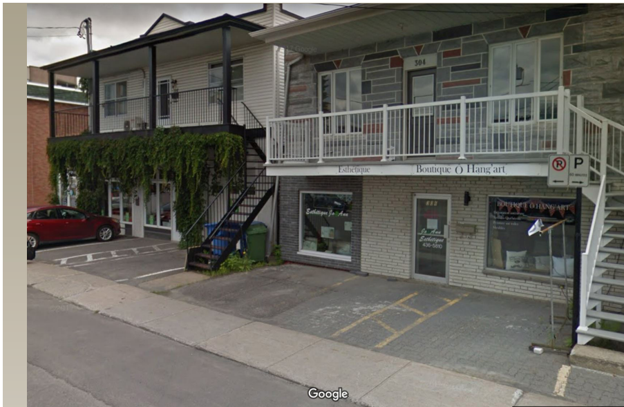
Figure 3 : Entrées d'autos rue de la Poterie
