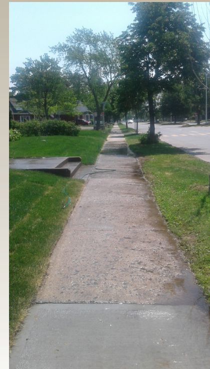
Photo 4: Zone tampon rue Place de Vaudreuil
